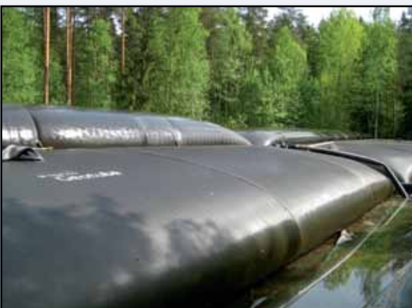
Geotubes können auch aufeinander gestapelt werden
