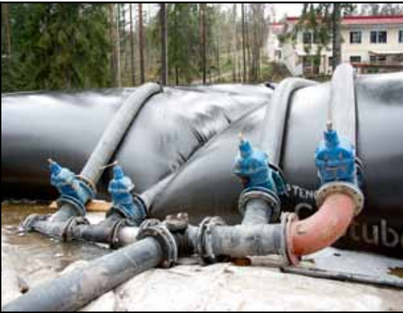
Pumpen in die Geotubes
