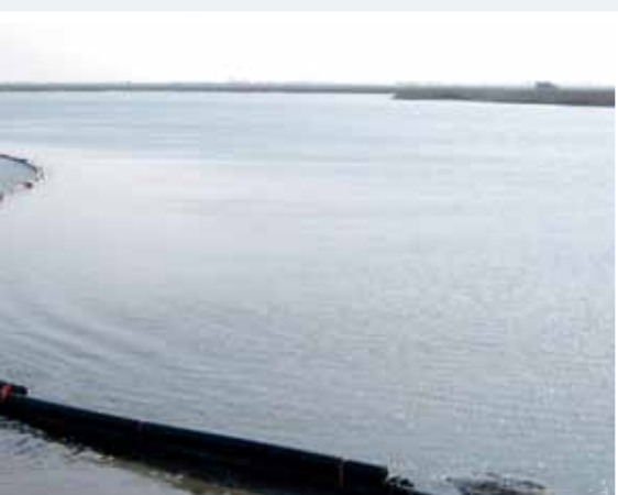
ugbaggerarbeiten in ochsiel
